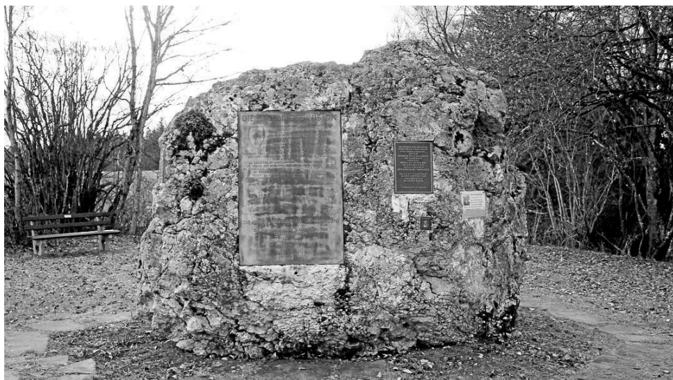
Zustand des Gedenksteines im Dezember 2023. Quelle: J. Berbalk
